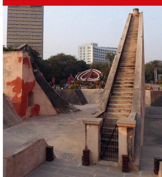
Abbildung 3: Samrath Yantra von Delhi. Im Vordergrund rechts ist der Gnomon (mit Treppe), links in der Bildmitte der zugehörige westliche Quadrant zur Ablesung der Schattenposition zu sehen. Der Betonboden verdeckt die untere Partie des Gnomons und der Quadranten. Ganz im Hintergrund in der Bildmitte ist das Misra Yantra zu sehen.
