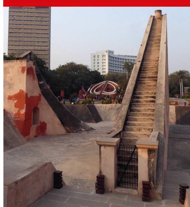
Abbildung 3: Samrath Yantra von Delhi. Im Vordergrund rechts ist der Gnomon (mit Treppe), links in der Bildmitte der zugehörige westliche Quadrant zur Ablesung der Schattenposition zu sehen. Der Betonboden verdeckt die untere Partie des Gnomons und der Quadranten. Ganz im Hintergrund in der Bildmitte ist das Misra Yantra zu sehen.
