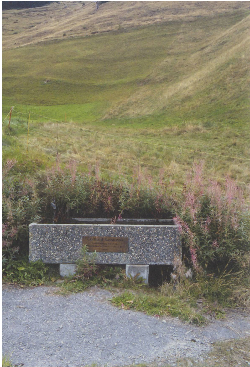
Gotthard-Basistunnel, 850 Meter tiefe Son- dierbohrung, Wasser- zufluss in 500 bis 700 Meter Tiefe, 1991 – ein Brunnen als Hinweis auf den Tunnel
