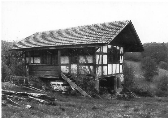
5 Gesamtaufnahme von Osten
