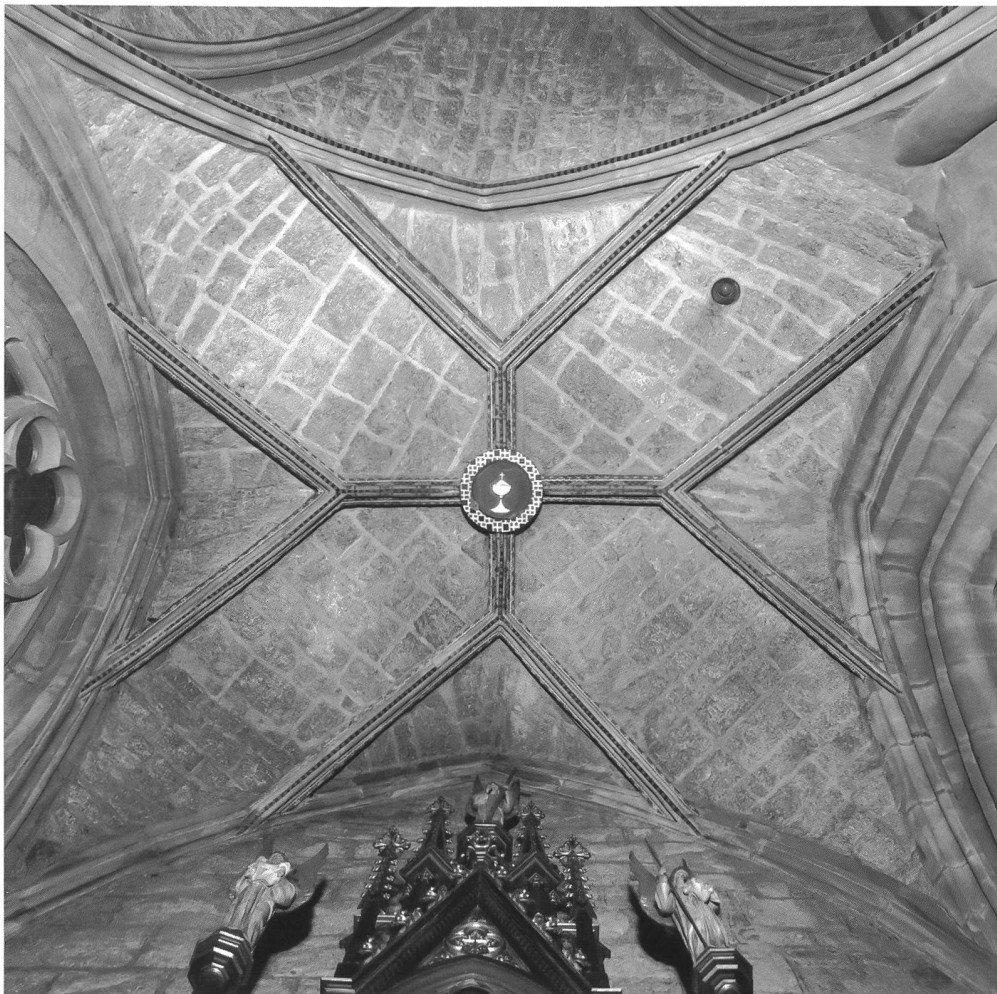
Fig. 42 Une seule voûte du bas-côté nord se singularise, celle de la chapelle du Clergé 13 , dédiée à sainte Anne et à saint Etienne et accolée au clocher; elle est visiblement plus récente par son réseau flamboyant particulier, en forme de croix largement pattée, sans croisée d'ogives mais à liernes et à faux tiercerons agrippés aux formerets, donc inscrite selon les axes. Il n'est guère possible de la situer dans le cadre régional avant la première apparition de ce type de voûtes, que l'on signale dans les années 1448/ 1453 à la Brügglerkapelle, à l'est du bas-côté sud du Münster de Berne – simplement adapté là à une disposition oblongue affirmée et non « carrée », qui est alors la marque des maîtres Ensinger (Ulm, Constance, Berne) et qu'on ne rencontre guère dans la région qu'à la Blanche Eglise de La Neuveville (chapelle médiane sud, v. 1458 ?) 14 et à St-Pierre de Bienne (chapelle sud-ouest) 15 . La date de consécration par l'évêque de Lausanne de l'autel St-Etienne dans la chapelle du Clergé, le 31 décembre 1456 16 conviendrait donc mieux à cet ouvrage et supposerait que la voûte des années 1430 avait été fortement endommagée par la ruine du clocher contigu lors de l'incendie de 1434, comme cela avait sans doute été le cas du chœur. Une seule voûte « carrée » de ce type se rencontre par la suite dans toute la région, celle de l'ouest de la chapelle de Buloz à St-Etienne de Moudon, mais elle date de 1522 et son tracé semble se compliquer à cause de la croisée d'ogive elle-même 17 (MG).
