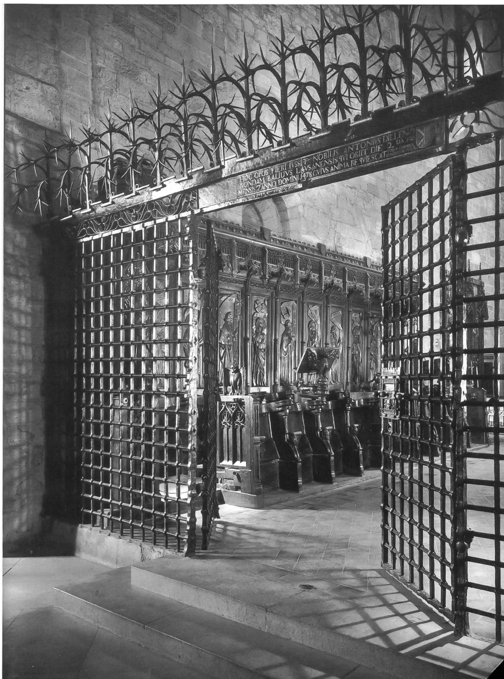
Fig. 32 La grille du chœur, attribuée aux serruriers Aymonet et Pierre Rochat, de Lausanne, 1478 ou peu après, fer forgé et peint. – En 1478, Antoine d'Il lens, ancien bailli épiscopal de Lausanne, lègue 200 florins pour exécuter cette magnifique grille hérissée d'épines. Comme à St-Nicolas de Fribourg, cette protection a été mise en place à la suite de la confection des stalles. Tout à fait semblable à la grille de l'église St-Laurent d'Estavayer-le-Lac, réalisée par les Rochat en 1506, celle de Romont a été attribuée au même atelier par Marcel Grandjean. Au-dessus de la porte à deux lourds vantaux, une plaque de fer porte l'inscription attestant le legs d'Antoine d'Il lens et la rénovation effectuée sur ordre du Conseil en 1765; les armoiries du donateur sont représentées sur le côté droit de cette plaque. Peinte en noir en 1890, elle avait sans doute une véritable polychromie à l'origine.
