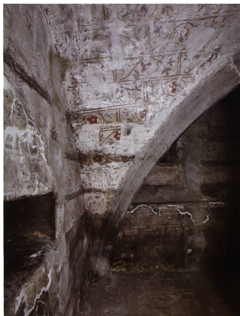
Fig. 58 Aile occidentale, salle gothique, 1320-1330. Le faux appareil avec rinceaux et rosettes couvre les murs et les voûtes. Abb. 58 Gotischer Saal im Westflügel, 1320/30. Die Quadermalerei mit Rosenranken überzieht Mauern und Gewölbe.
