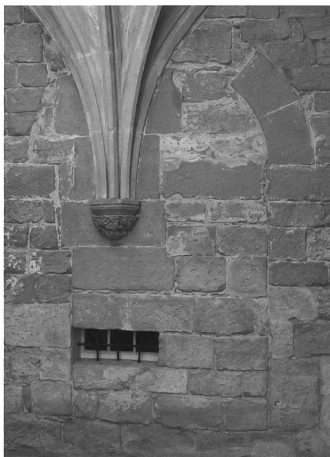
Fig. 31 Vestiges de l'ouverture, murée, de l'ancien accès au réfectoire des convers depuis la galerie occidentale. Abb. 31 Reste der vermauerteten ursprünglichen Tür vom Westflügel in das Konversen-Refektorium.
