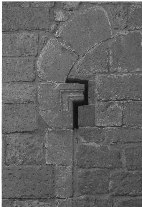
Fig. 37 Ancienne porte s'ouvrant de la galerie orientale sur la salle des moines: détail du corbeau sommant son piédroit nord.
