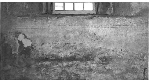
Fig. 41 Porte et fenêtre de la façade ouest, 1320-1330. Abb. 41 Tür und Fenster in der Westfassade, 1320-1330.
