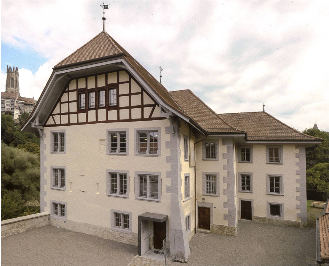
Fig. 95 La commanderie en 2013. – Mis à part l'entrée du Service des biens culturels protégée par un portique sur la façade pignon et l'annexe de 1864, le bâtiment a retrouvé son lustre de 1699, à l'époque des commandeurs Duding rappelés par les panonceaux des épis de faîtage.
