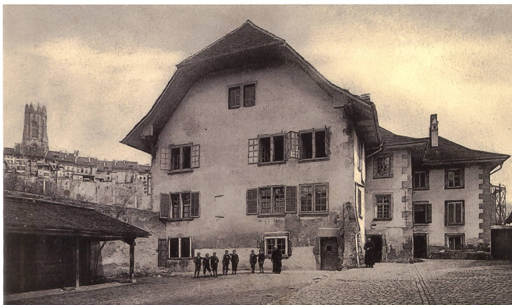
Fig. 88 La commanderie au temps de l'Internat St-François de Sales, avec quelques élèves du Technicum et deux Frères Maristes. Le bâtiment possède encore son crépi d'origine et ses chaînes d'angle harpées peintes qui ont servi de modèle à celles, maçonnées, de l'annexe sud, en 1864.
