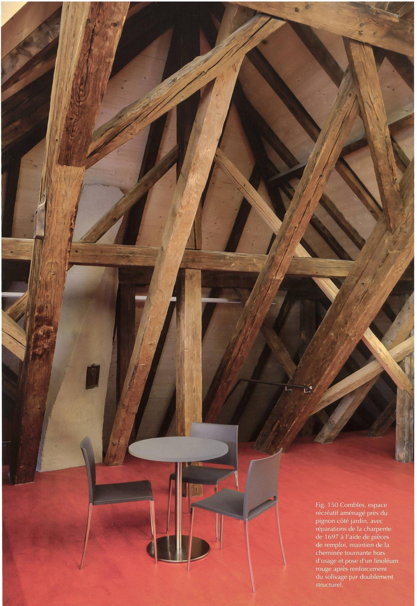
Fig. 150 Combes, espace récréatif aménagé près du pignon côté jardin, avec réparations de la charpente de 1697 à l'aide de pièces de remplissage, maintien de la cheminée tournante hors d'usage et pose d'un linoléum rouge après renforcement du solivage par doublement structurel.
