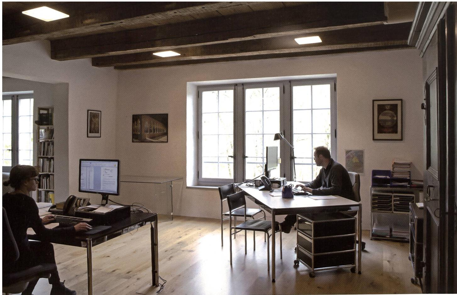
Fig. 140 1<sup>er</sup> étage, bureaux est, côté pré, avec solivage de 1305-1306, la plus ancienne structure visible du bâtiment.
