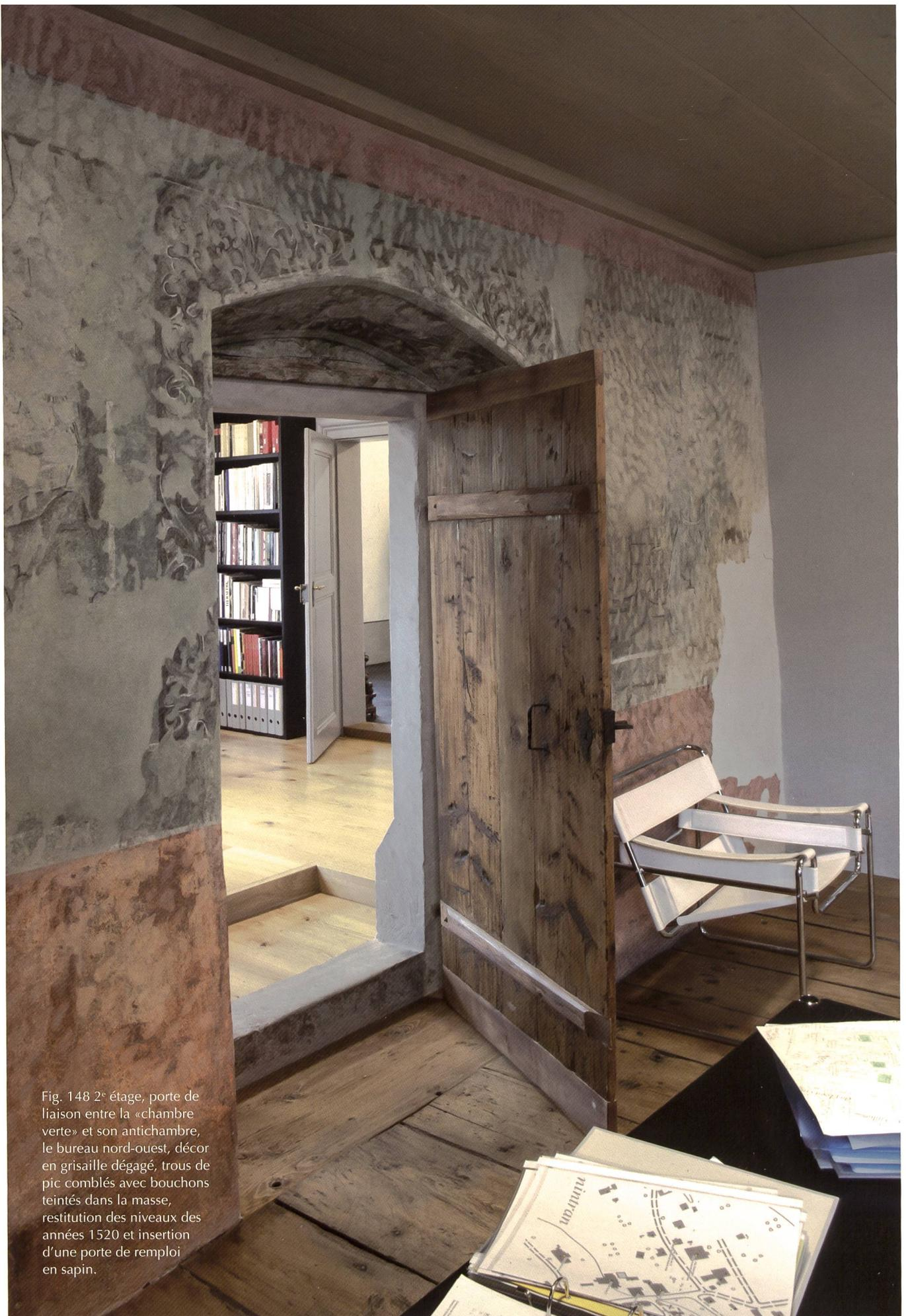
Fig. 148 2<sup>e</sup> étage, porte de liaison entre la «chambre verte» et son antichambre, le bureau nord-ouest, décor en grisaille dégagé, trous de pic comblés avec bouchons teintés dans la masse, restitution des niveaux des années 1520 et insertion d'une porte de remploi en sapin.
