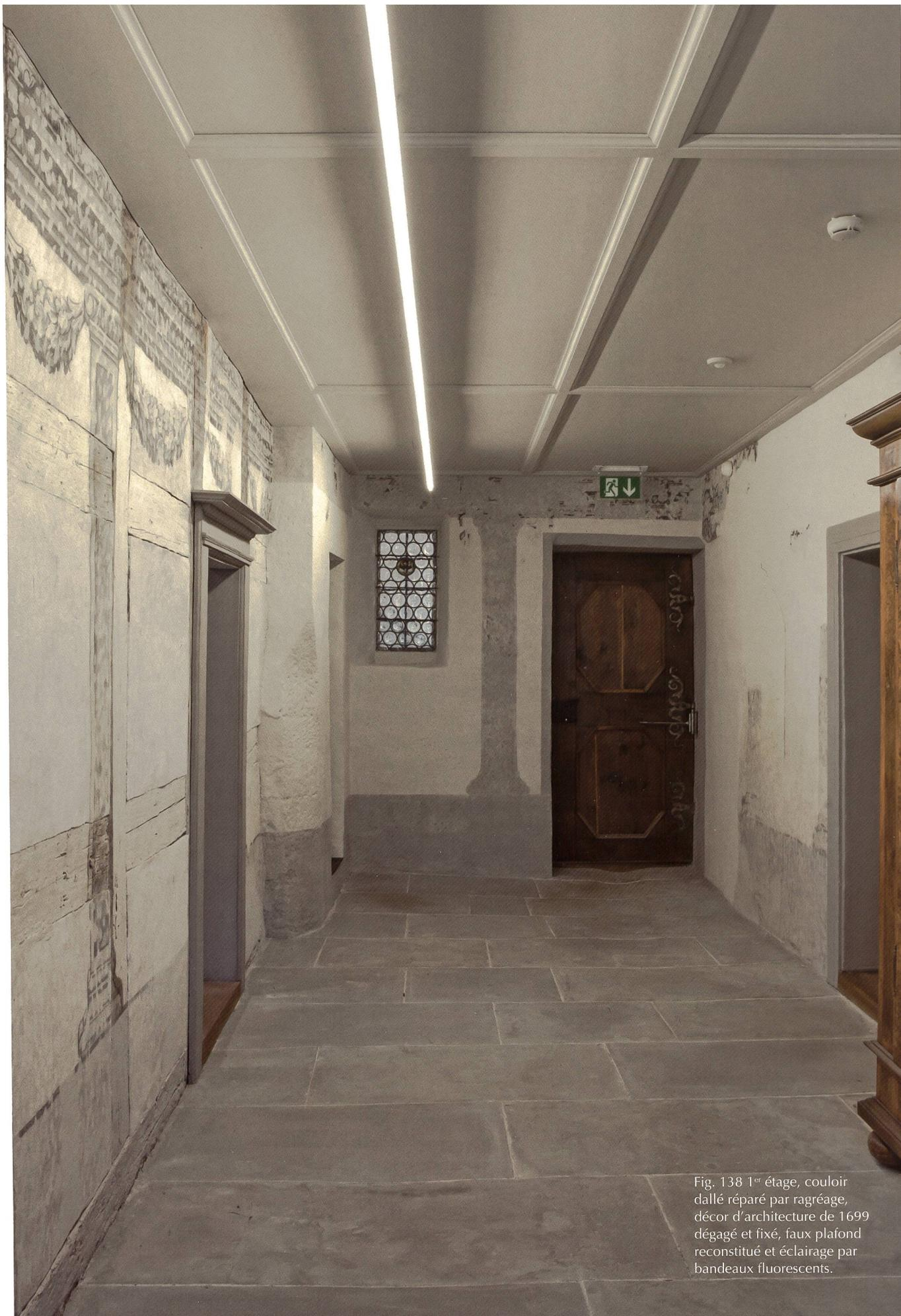
Fig. 138 1<sup>er</sup> étage, couloir dallé réparé par ragréage, décor d'architecture de 1699 dégagé et fixé, faux plafond reconstitué et éclairage par bandeaux fluorescents.
