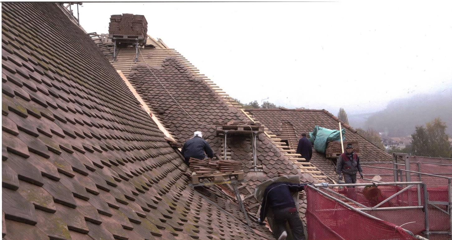
Fig. 131 Travaux de couverture et de ferblanterie après la pose de l'isolation sur chevrons ayant nécessité de découvrir un toit en parfait état puisque refait avant le début du chantier.
