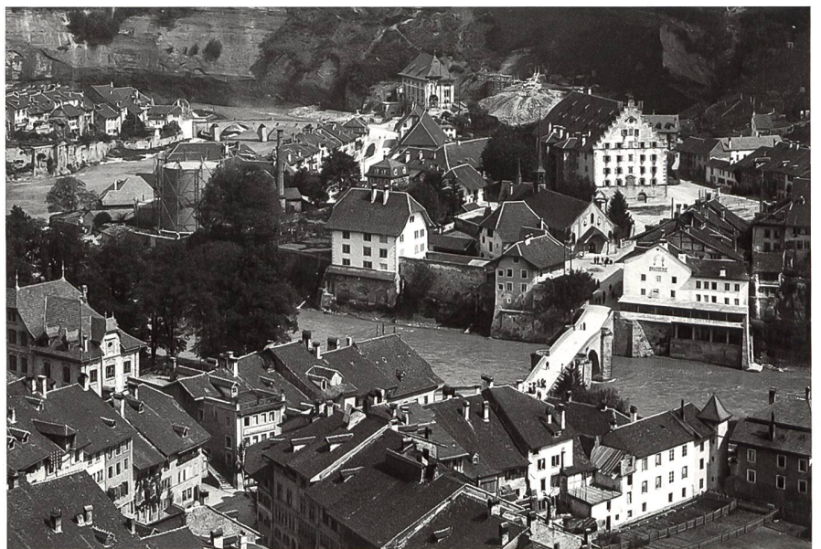
Fig. 170 La Planche peu après 1901, avec l'usine à gaz fondée en 1861, la commanderie servant de prison depuis 1820, aux murs repeints en 1889, la dépendance et l'église Saint-Jean avec leurs anciennes façades. – Un mur intérieur de plus de 3 m de haut, parallèle à l'enceinte côté Sarine, lie la maison de correction à la cure. Il définit une cour de moins de 260 m 2 réservée aux détenus, un tout petit espace de liberté à l'abri des regards.
