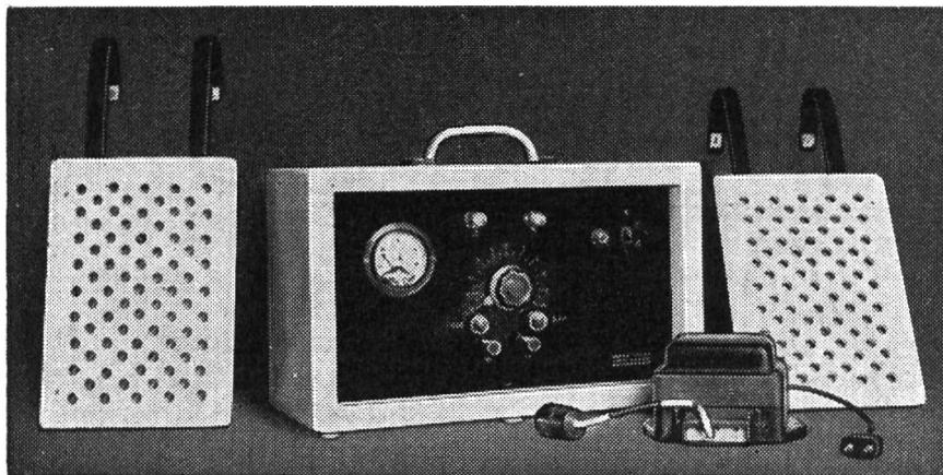
*Badegleichrichter mit Vortransformator und zwei Elektroden. In der Regel werden 3—6 Elektroden für alle Applikationen mitgeliefert.*
