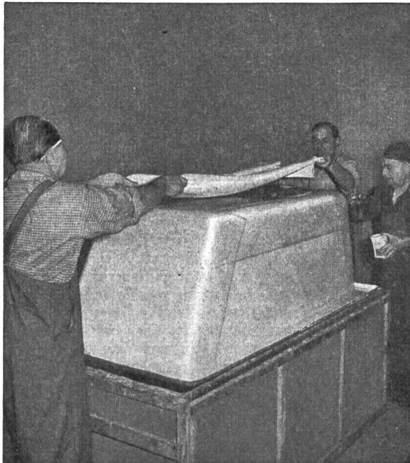
tung ist bei Raumtemperatur in einem Tag erfolgt. Bei erhöhten Temperaturen, z. B. durch Infrarot-Bestrahlung oder Erwärmung der Form erfolgt die Härtung entsprechend schneller. Nach Auflegen der letzten Lage Glasgewebe wird die Oberfläche mit einer entsprechenden Kunststoff-Folie überdeckt, wobei eine glatte äussere Oberfläche erzielt und die Wanne
