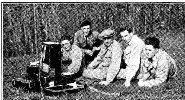
Die Bodenstation in Oberrüti bei Kloten.
