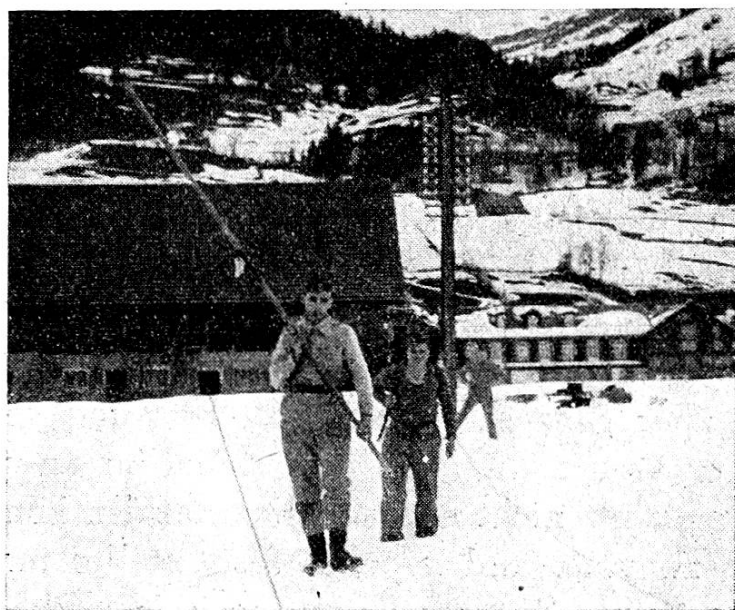
Kabellinienbau für das Slalomrennen Hegmatt—Engelberg.
