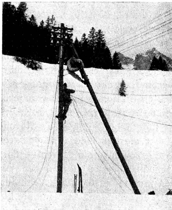
Ein willkommener Stützpunkt für 10 Militärkabelleitungen.
