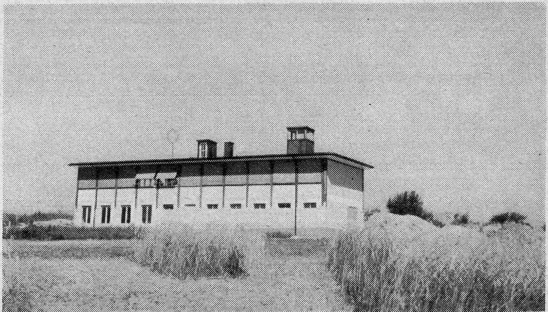
Peilgebäude in Oberglatt. Auf dem Dach des Gebäudes sind die drehbare Peilantenne und der Aufbau für die Beobachtung der Anflüge sichtbar.
