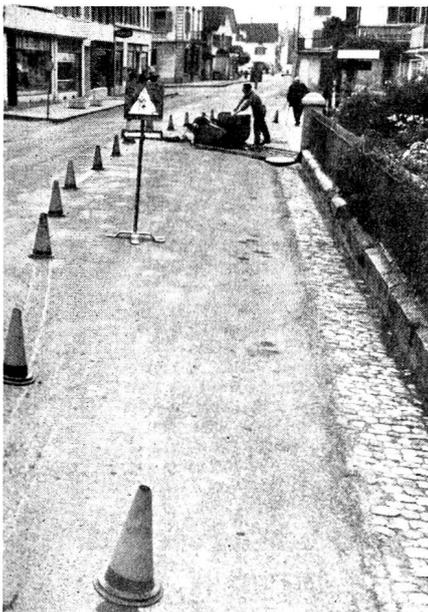
**Bild oben links:** Diese runde Kanalisation von 1 m  $\phi$  wurde zufolge Rückstaus abgedrosselt. Sie wird nun mit dem Stäbchenstrang durchbohrt, um ein Traktionskabel unterirdisch durchzuziehen, um die Leitung mit den Klappdeckelkratzern und Bürsten zu befreien und die Ablagerungen auf den Seegrund zu führen.
