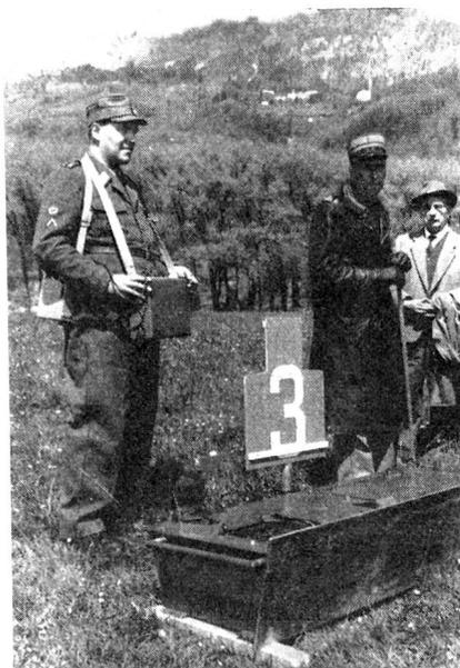
*Eine der Scheiben und das Funksteuergerät der neuen Scheibenanlage «Zschokke», wie sie im Bericht geschildert wird (Photopress).*
