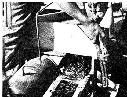
Lostrennung der Brücke vor der Verschiebung
