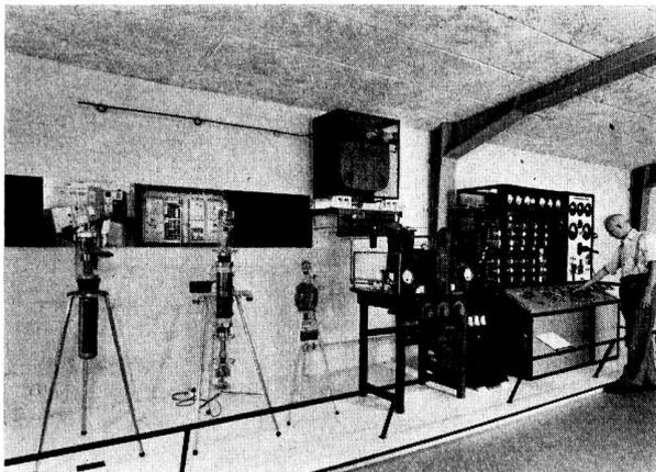
Die erste Sendeanlage für Radiorundspruch in der Schweiz, Champ-de-l'Air, Lausanne. In Betrieb genommen im Jahre 1923. Links im Bild diverse damals verwendete Röhrentypen.
