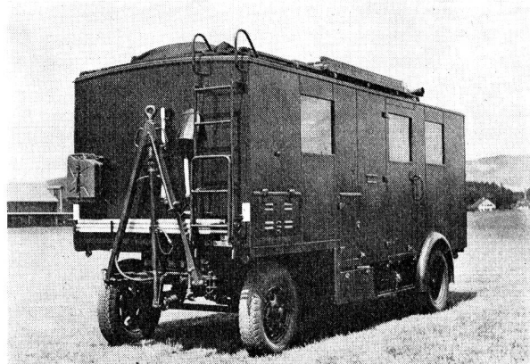
Abb. 40. Zweiachs-Kastenanhänger zur Unterbringung von Feldzentralen und Fernschreibstationen. Modell 1948.
