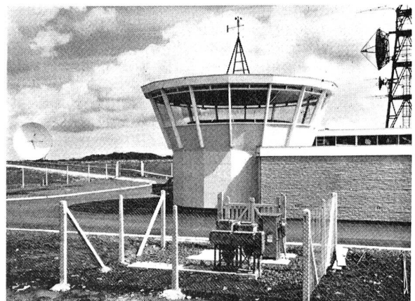
Fig. 3. Poste de contrôle de la station terrienne pour satellites de Goonhilly Downs pendant une transmission télévisuelle (Photos: General Post Office)
