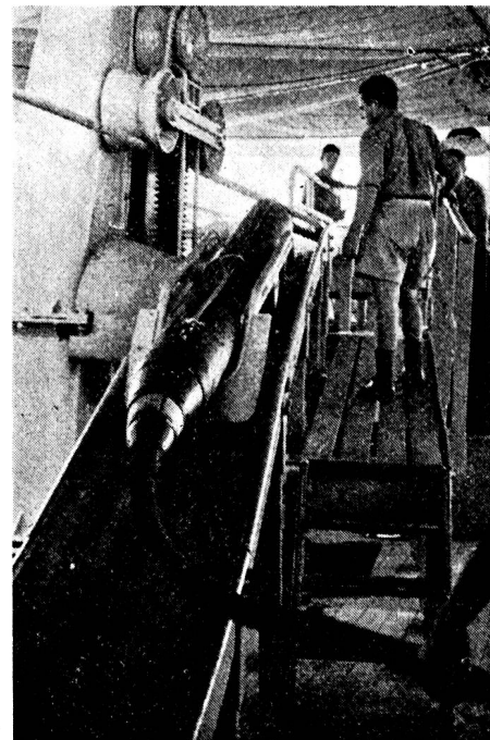
Verstärker und Kabel werden über eine Rampe des Kabellegers im Meer versenkt.
