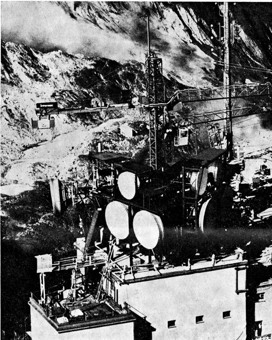
Parabolantennen in den Alpen mit Witterungsschutz-Ueberzug sind Windgeschwindigkeiten bis 200 km/h und Temperaturen zwischen  $-31,5$  Grad C und plus 30 Grad C ausgesetzt.
