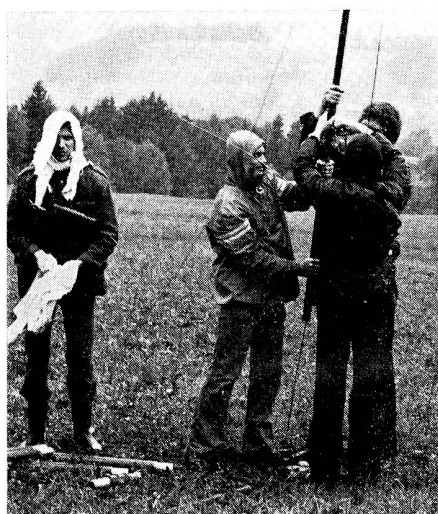
Die Arbeit beim Antennenbau in strömendem Regen hat seine Reize!
