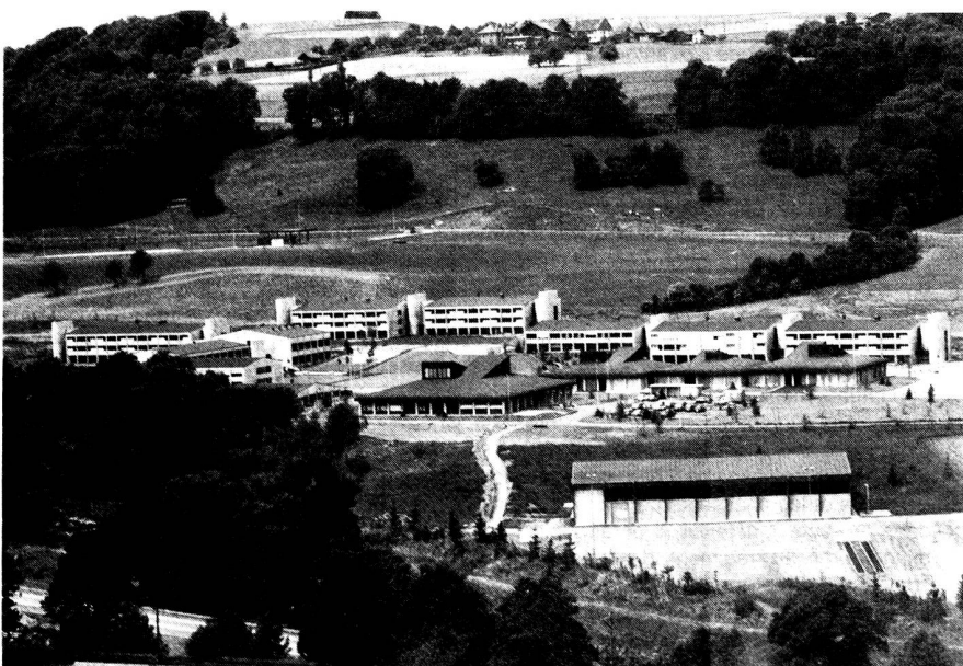
La nouvelle caserne à Moudon
