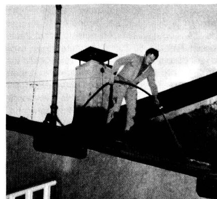
Der Präsident beim Dachreinigen
