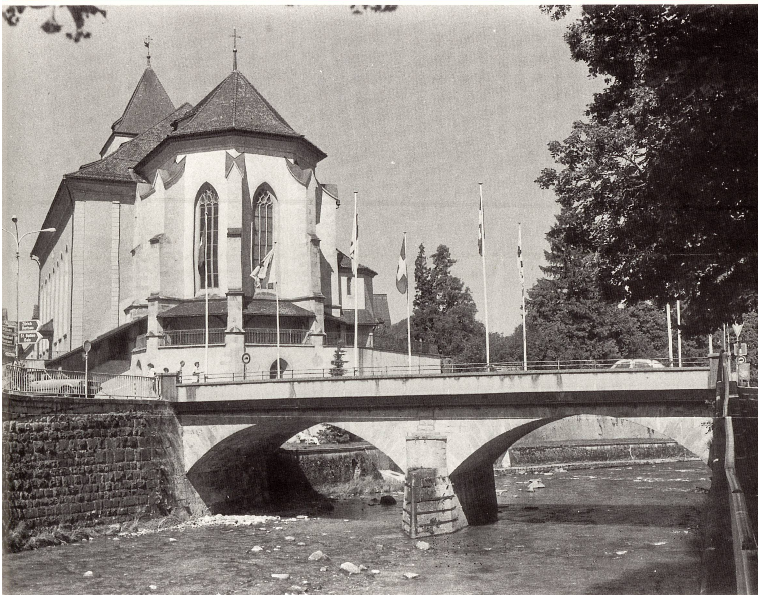
Pfarrkirche mit Sitterbrücke (Appenzell)
