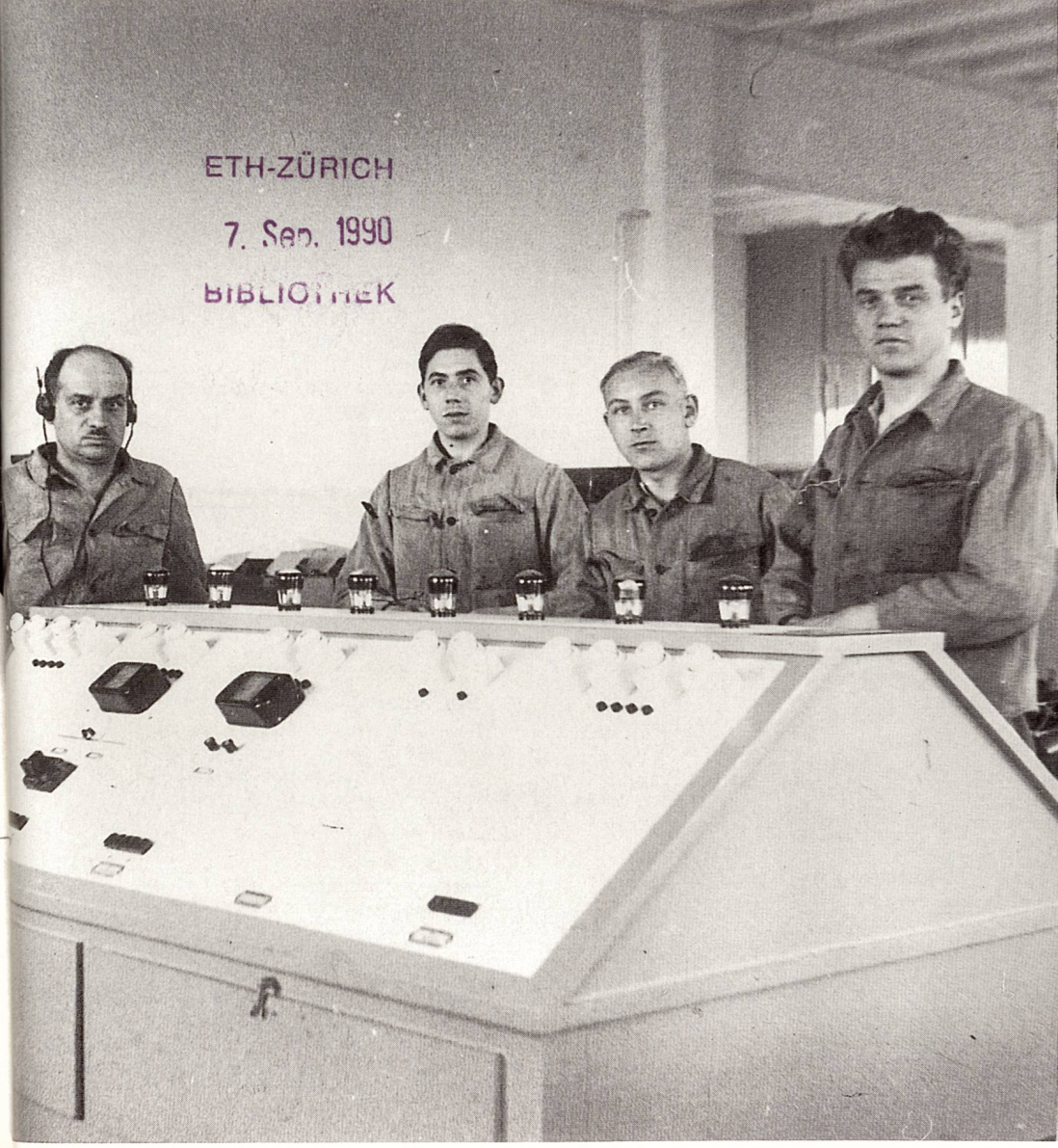
Prüffeld im Zeughaus Bern. (Archiv Schlatter)
