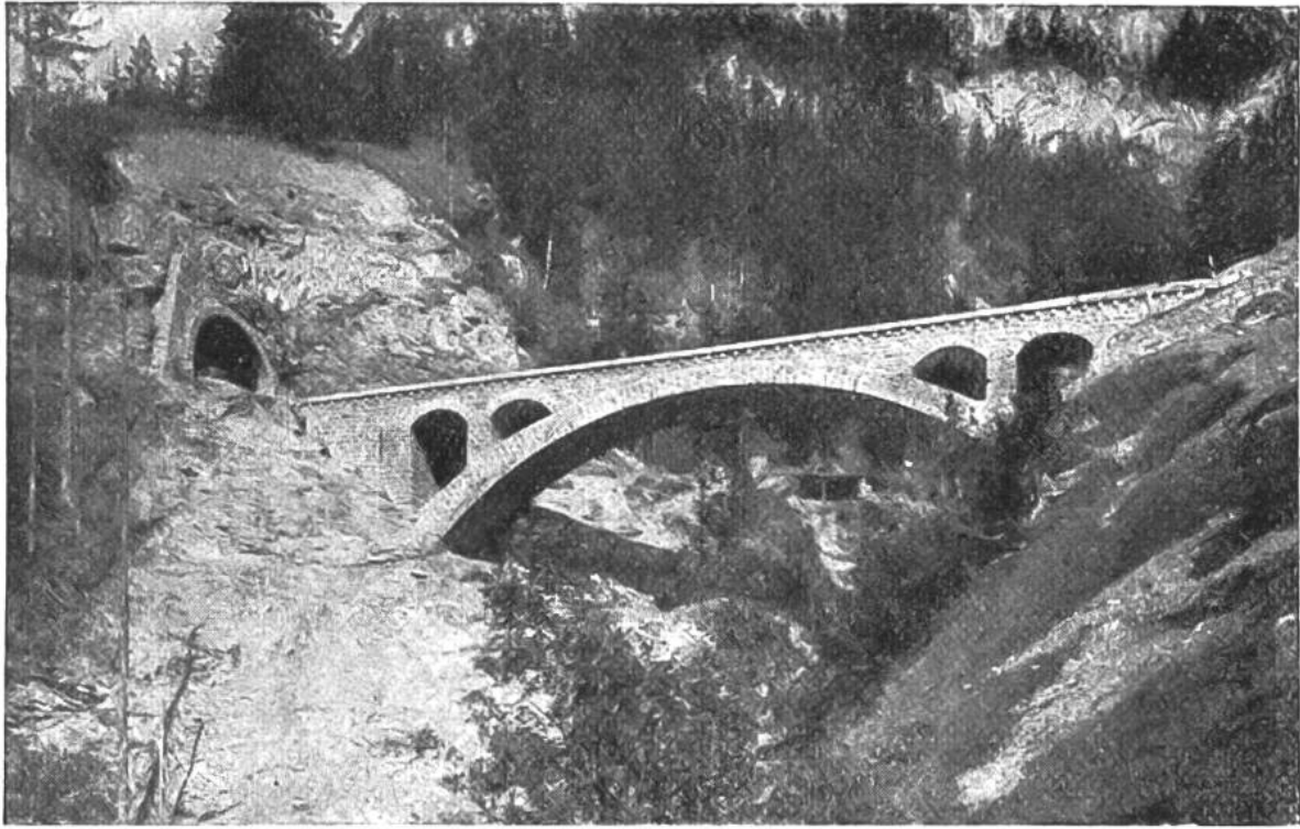
Berner Alpenbahn, Rotenbachbrücke bei Mittholz.
