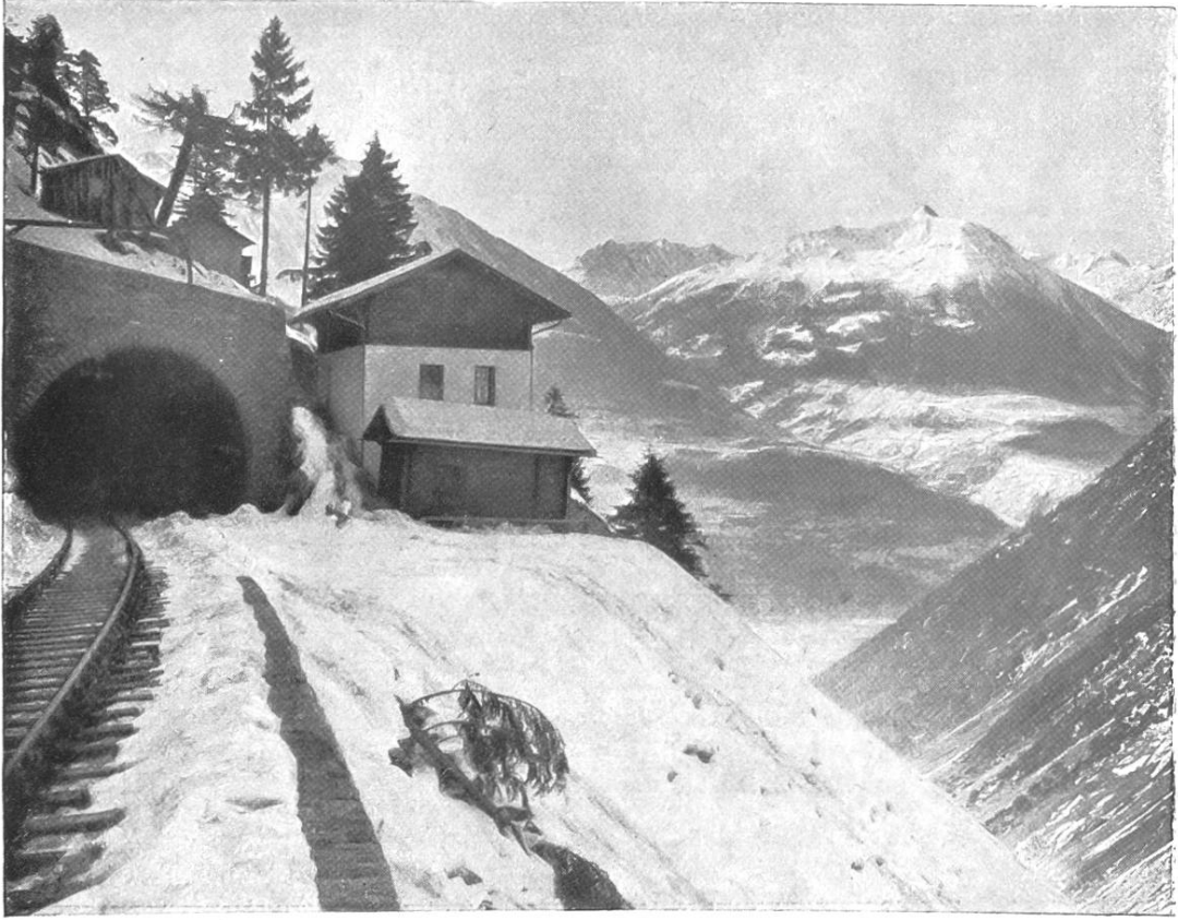
Berner Alpenbahn, Rotlaitunnel zwischen Goppenstein und Hothen.
