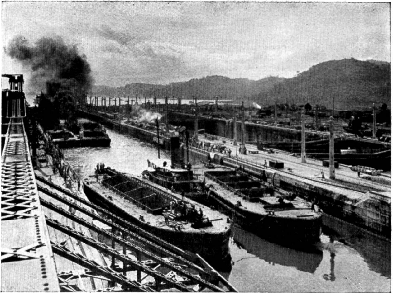
Schleusen vor dem Culebradurchstich mit Arbeitsbooten und kleinen Schleppdampfern.
