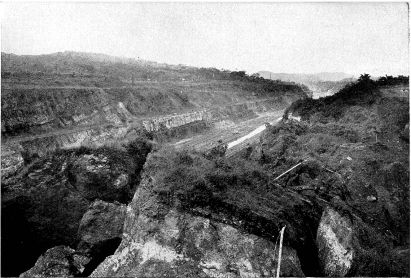
Der Culebradurchstich. Das Bild lässt erkennen, welch gewaltige Massen Erde hier beseitigt werden mussten, um dem Kanal Platz zu machen.
