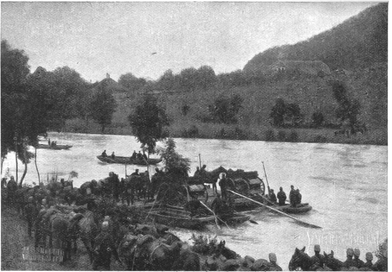
Aareübergang bei Bern. Bei der Neubrücke in Bern wurde übungsweise Artillerie und Kavallerie auf einer „fliegenden Brücke“, die man aus Pontons und Brettern erstellt hatte, über den Fluss gesetzt.
