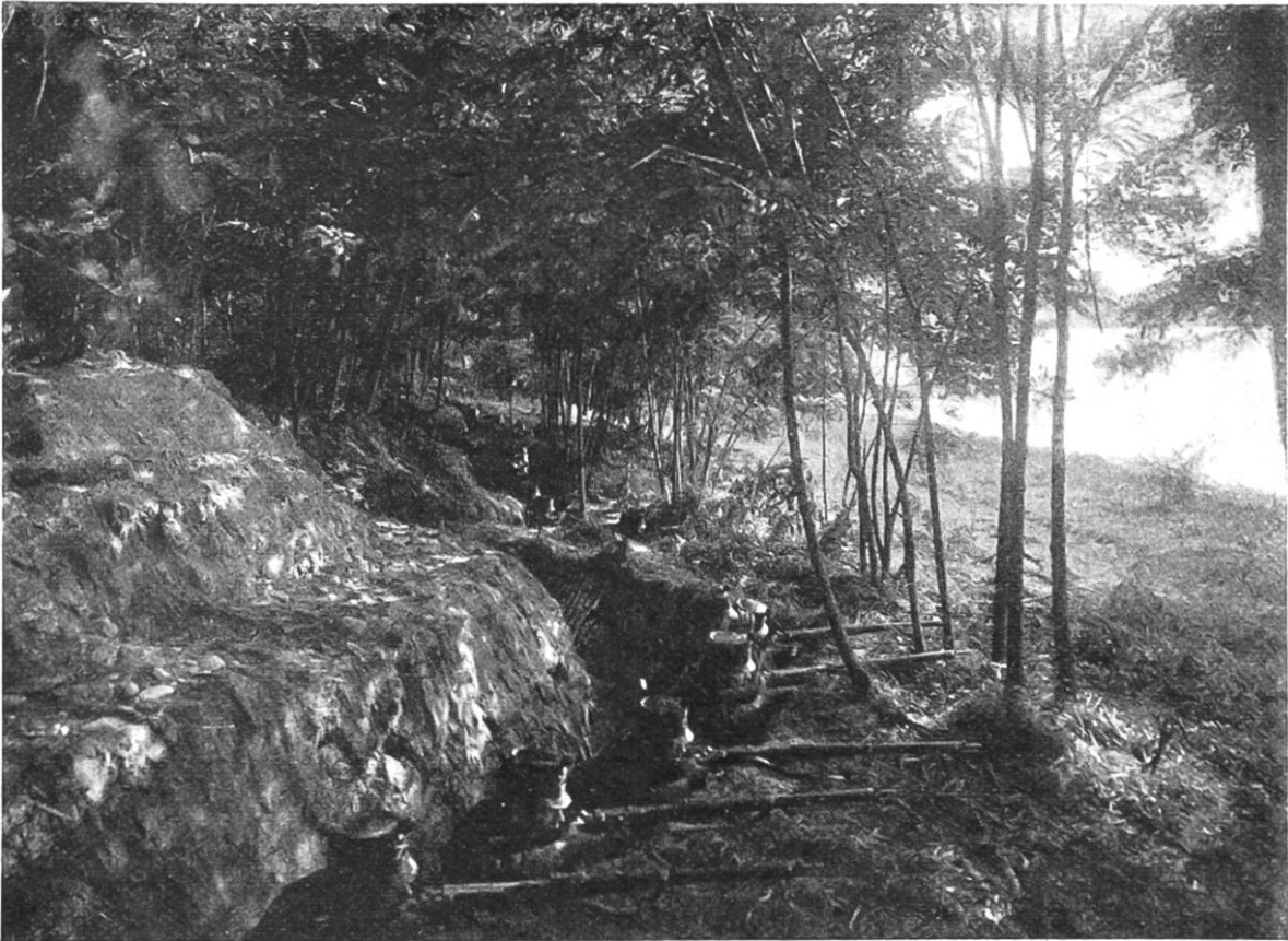
Schützen der IV. Division im Schützengraben am Waldrand. Gut sichtbar sind die seitlichen Splitterwehren und die möglichst unauffällige Maskierung des Grabens nach der Feldseite hin.
