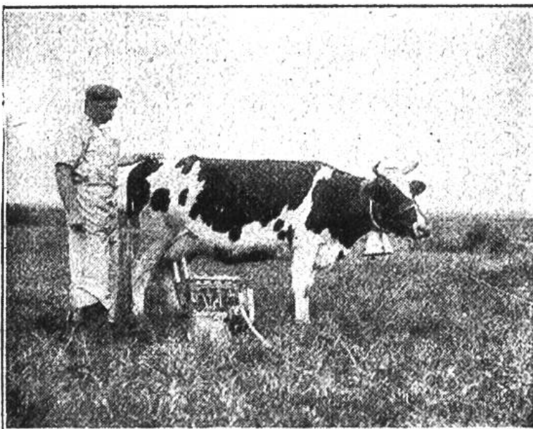
Der elektrische Melkapparat.
