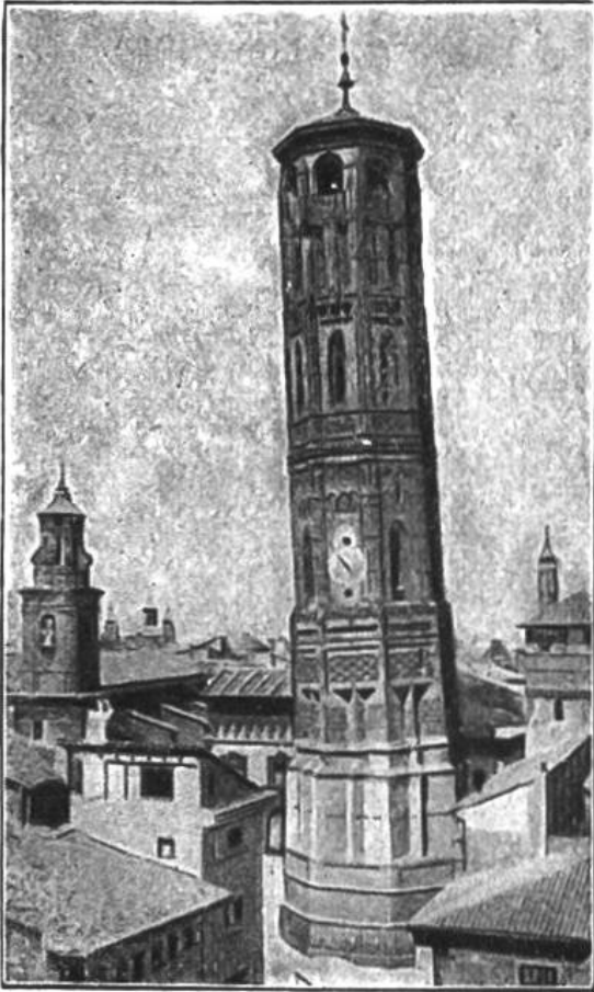
Der schiefe Turm von Saragossa in Spanien.
