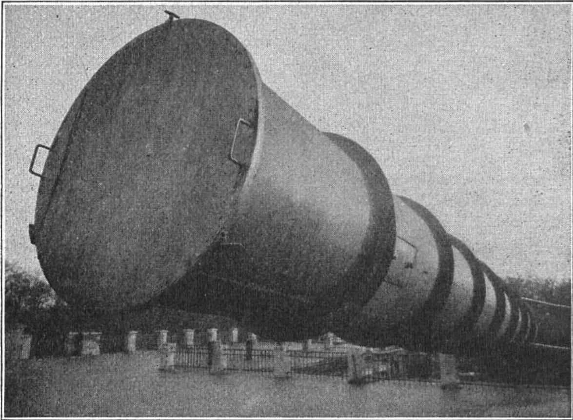
Eine „Riesenkanone“, mit welcher der Sterngucker Blicke auf ferne Sternenwelten „schießt“ : das mit Deckel geschlossene Fernrohr der Sternwarte Berlin-Treptow. Das Rohr, eines der grössten in Europa, ist 21 m lang bei einem Durchmesser von 1,40 m.
