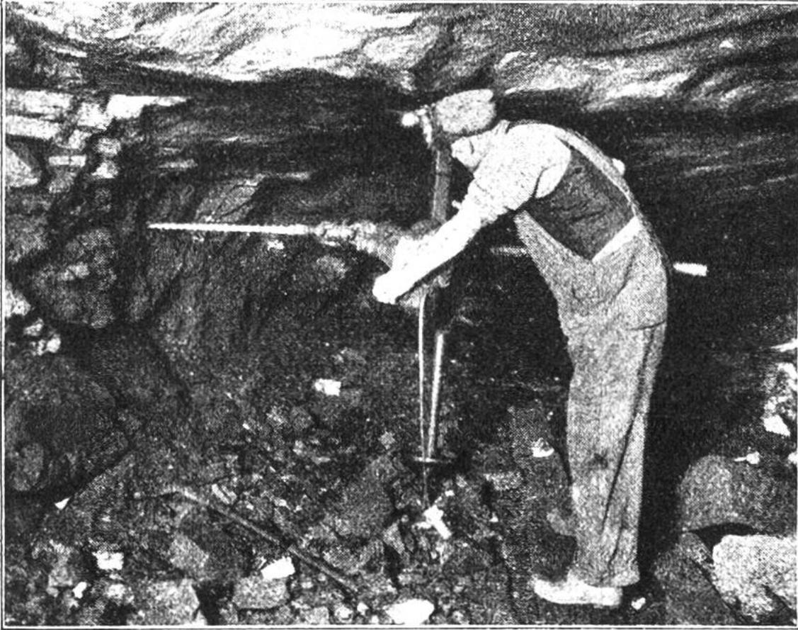
Mineur mit elektrischer Bohrmaschine in einem Bergwerk von Pennsylvania (Vereinigte Staaten von Nordamerika). Die Bohrlöcher werden mit Sprengstoff gefüllt, der, mit elektrischer Zündschnur zur Explosion gebracht, die Kohle losbricht.
