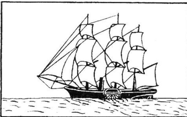
**1819** kreuzte das 1. Dampfschiff, d. amerik. **„Savannah“**, den Ozean vom Hafen Savannah aus nach Liverpool. Das Schiff besass 2 Schaufelräder und ausserdem noch Segel; es fuhr 18 Tage mit Dampf, den Rest mit Hilfe der Segel.
