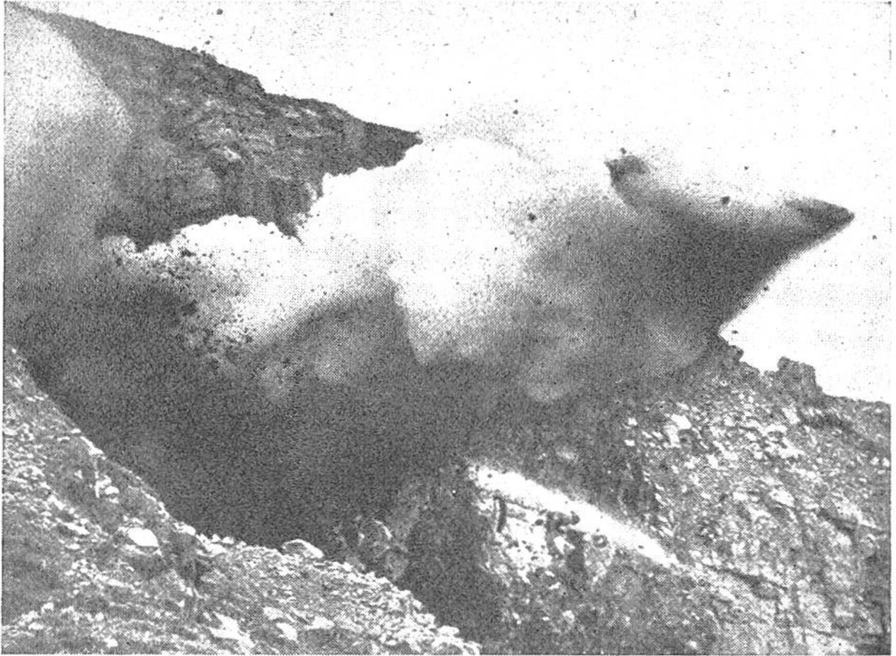
Dynamit als unschätzbare Helfer bei friedlicher Arbeit. 100 000 t Felsen werden mit Dynamit auf einmal gesprengt. Das Gestein wird beim Bau einer neuen Bahnlinie benötigt. Die Entzündung des Sprengstoffes erfolgte auf elektrischem Wege und zwar aus 250 km Entfernung. Bei einer kleinen Feier, die in London anlässlich des Ereignisses veranstaltet wurde, drückte der Direktor der Eisenbahngesellschaft auf einen elektrischen Schaltknopf und im gleichen Moment erfolgte die Sprengung der Felsmassen.
