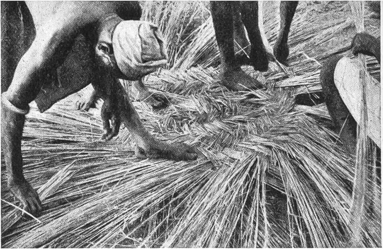
Die Wände der Hütten werden aus Schilf geflochten.
