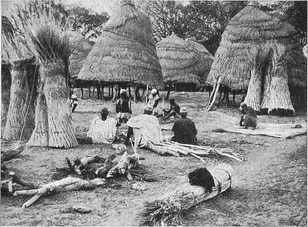
Einige Hütten stehen schon, für die andern ist das gesamte Baumaterial bereitgestellt.
