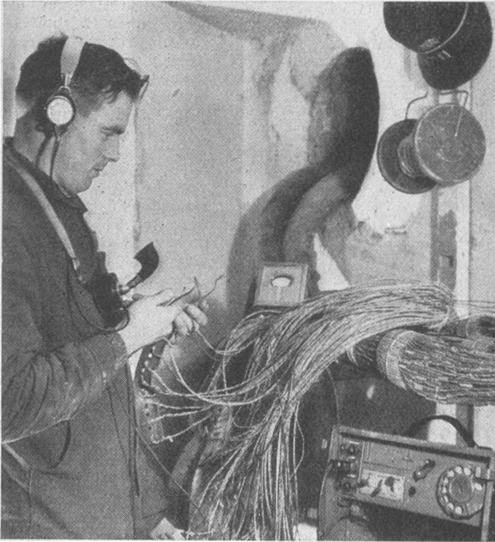
Kabelsplessen (Zusammensetzen zweier Kabelstücke) in einem unterirdischen Kabelstollen.
