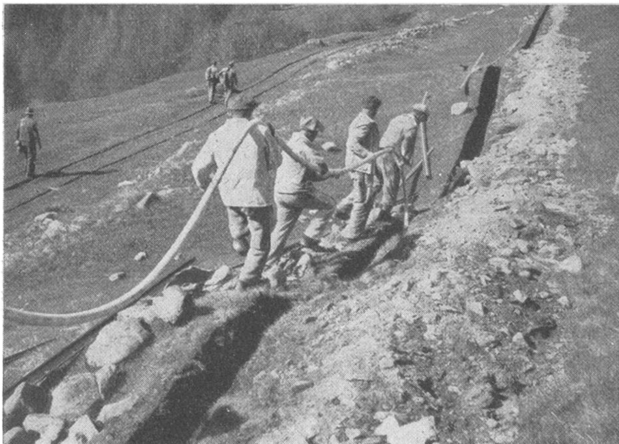
Auslegen eines Fernkabels; es kommt in den vorher ausgehobenen Graben.
