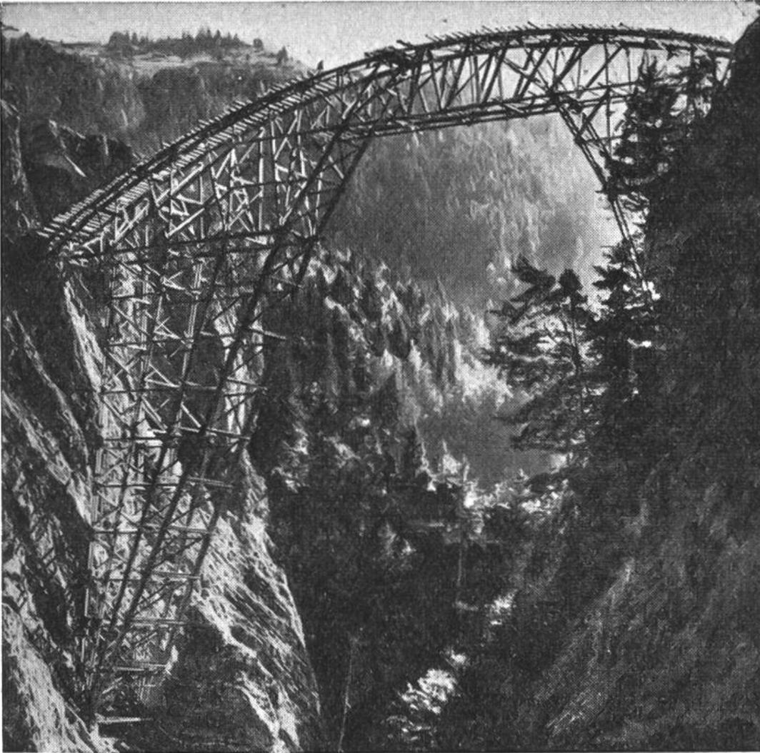
Abb. 6. Gerüst der Salgina-Tobel-Brücke von 90 m Spannweite.
