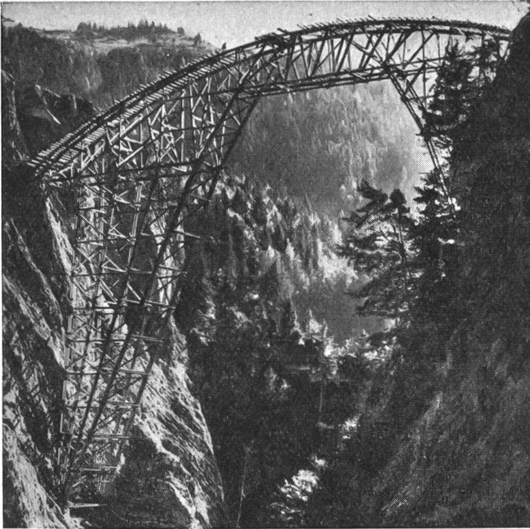
Abb. 6. Gerüst der Salgina-Tobel-Brücke von 90 m Spannweite.
