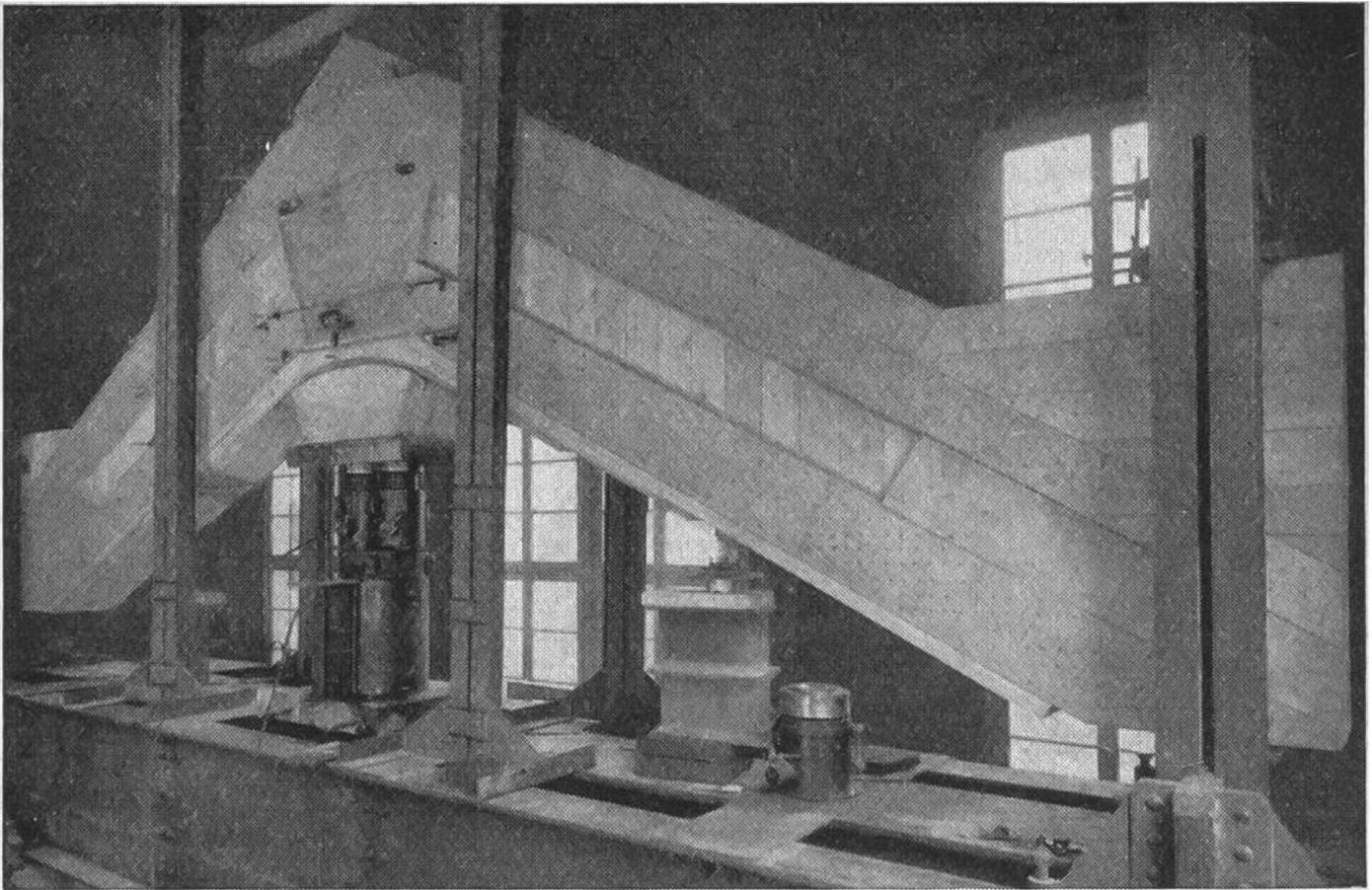
Abb. 5. Biegeversuch an einem Teil eines Hallenbinders aus vernagelten Brettern. In der Mitte eine 150 Tonnen-Pressen.
