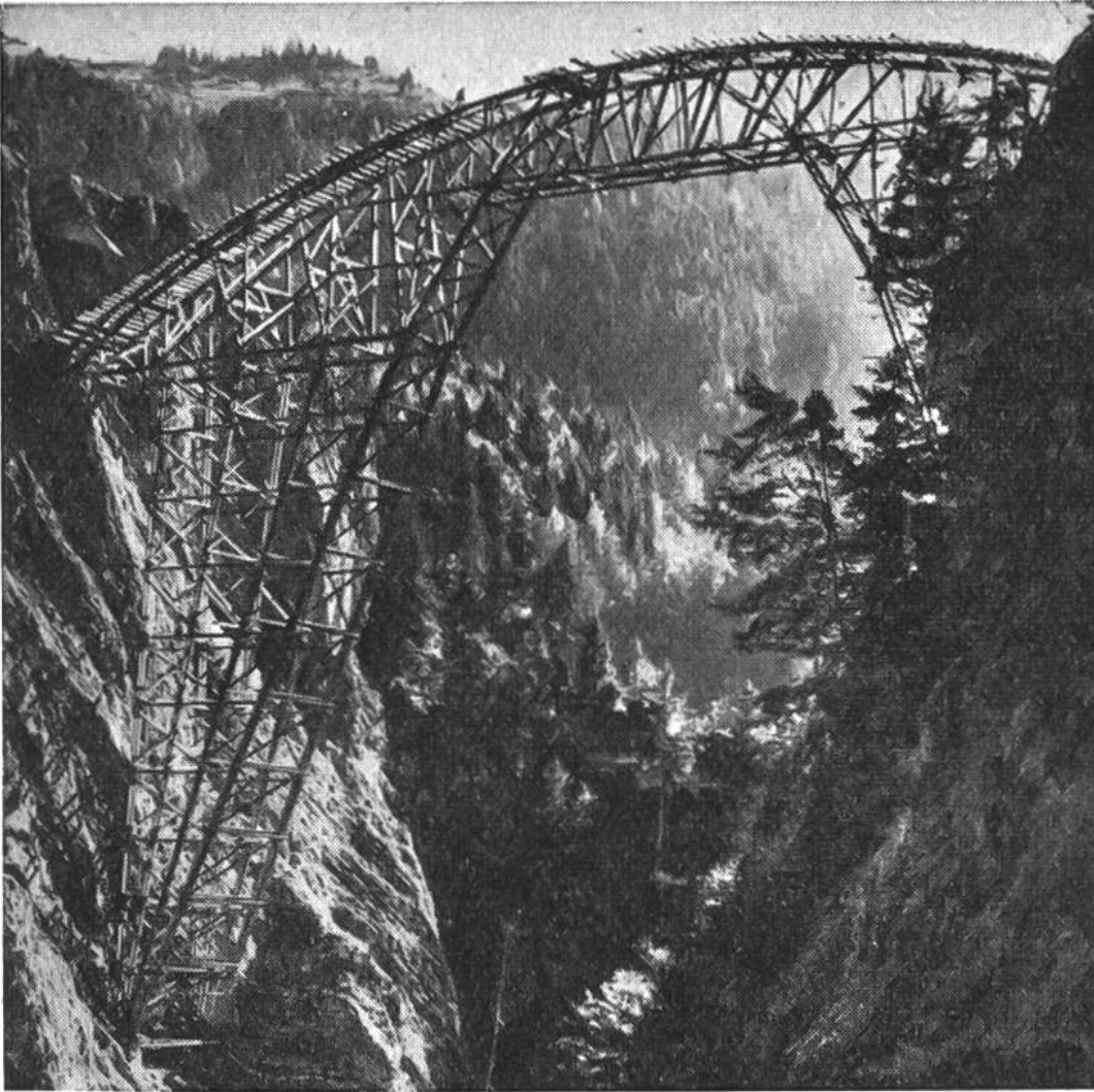
Abb. 6. Gerüst der Salgina-Tobel-Brücke von 90 m Spannweite.
