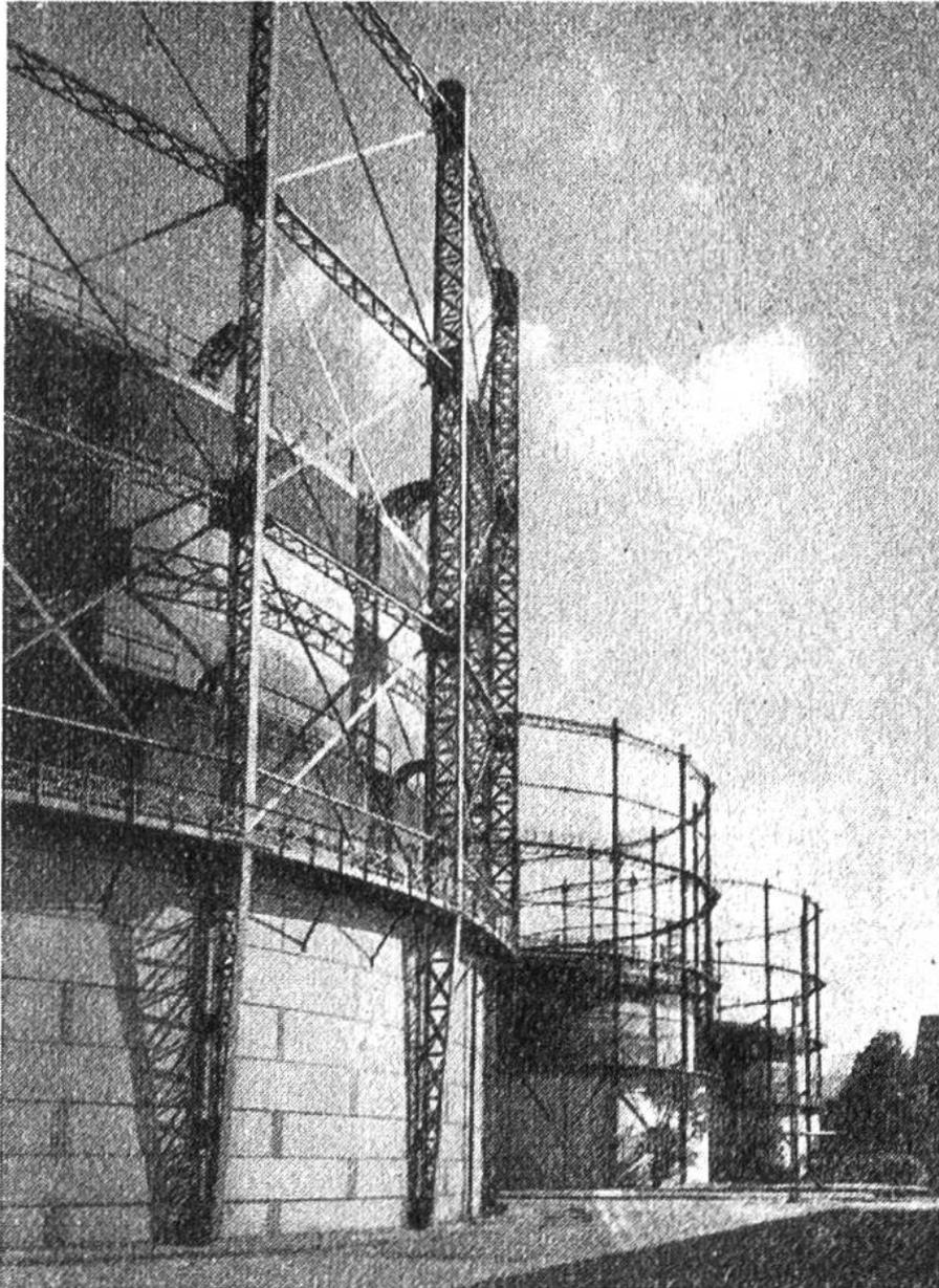
Riesige Gasbehälter von 20 000 – 100 000 m<sup>3</sup> Inhalt speicherndas Gas für Spitzenbedarf (z. B. über Mittag).
