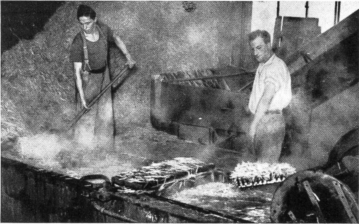
Holzdrahtstücke ohne Zündkopf werden in einem chemischen Bad imprägniert.
