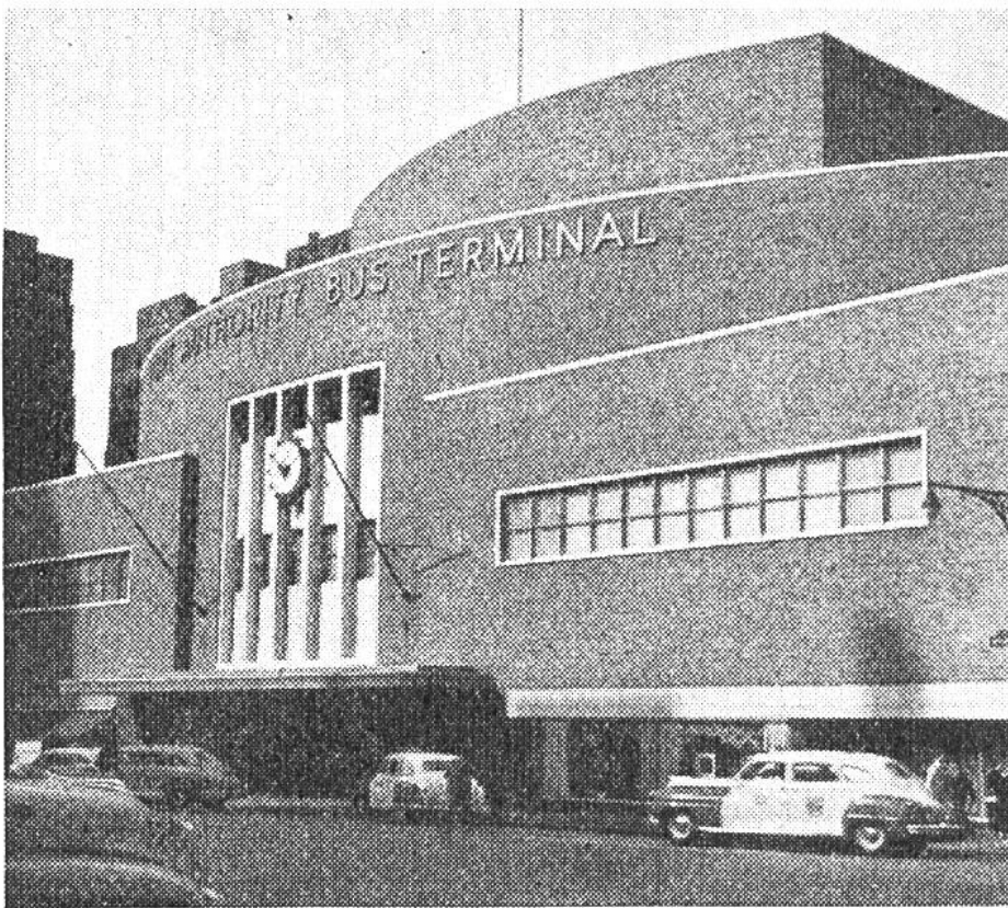
Die Fassade des modernen Auto-bus-Bahnhofs in Manhattan. Der Beschauer kann sich kaum vorstellen, welch
