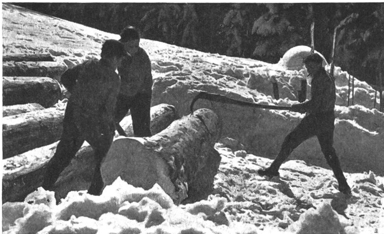
Verladen von Trämeln mit Hilfe von Sparren, Kehrhaken und «Zapi» (rechts).
