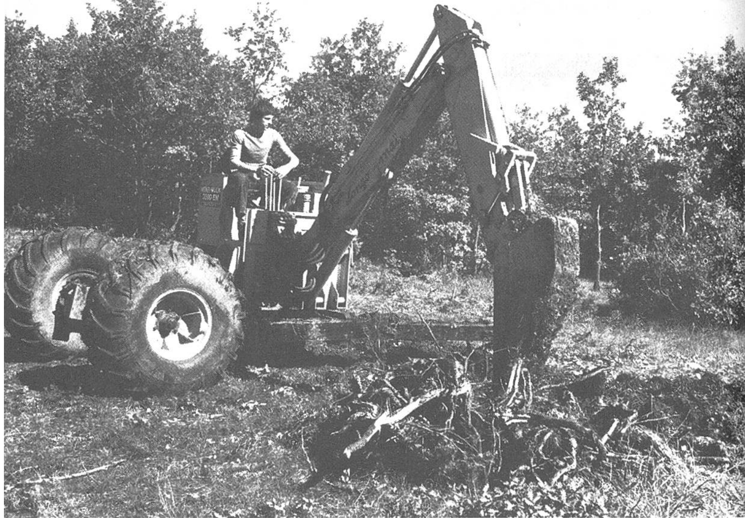
Mit Bulldozern und anderen Maschinen wird Wald gerodet und gelichtet: hier werden Wurzeln ausgerissen, damit Getreide gepflanzt werden kann.
