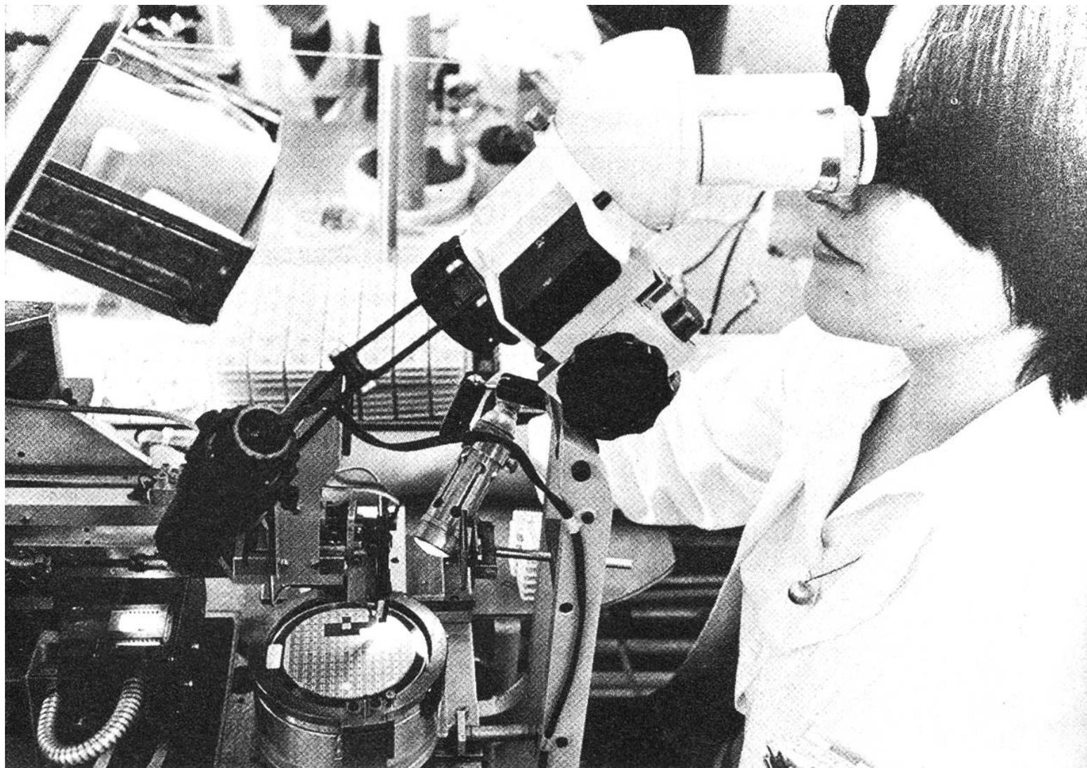
*Mikroprozessoren müssen mit elektrischen Anschlüssen versehen und in eine schützende Umhüllung gebracht werden. Auch dies besorgen Automaten, doch der Mensch muss deren Funktion überwachen. Das kann er in diesem Falle freilich nur mit Hilfe stark vergrößernder optischer Instrumente.*
