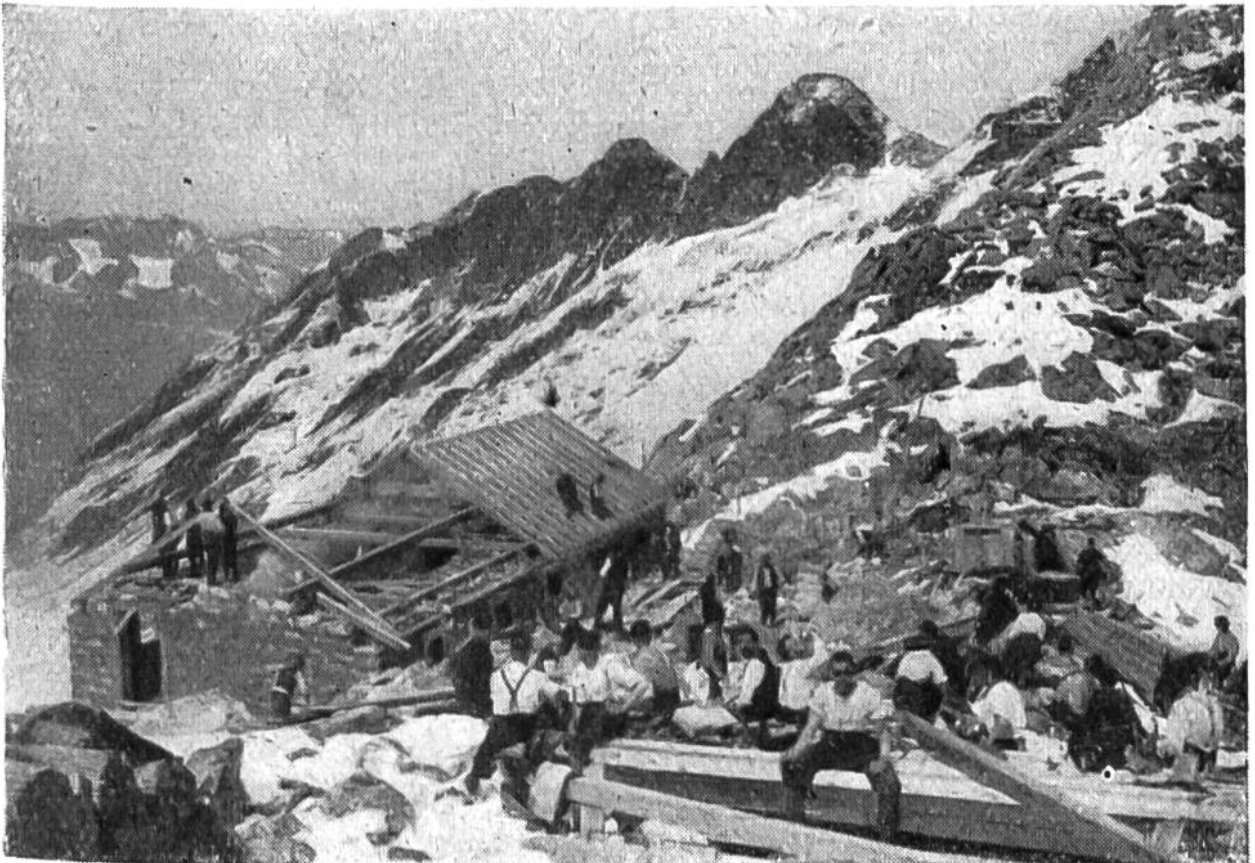
Aufbau einer Baracke durch Sappeure.
