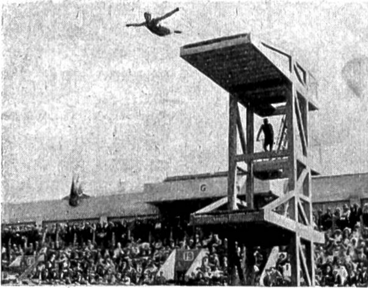
Abbildung Nr. 8. Kopfsprung vorwärts von der 10 m-Plattform an der 8. Olympiade in Paris 1924. Der Sprungturm ist, wie die gesamte Anlage, aus armiertem Beton gebaut.
