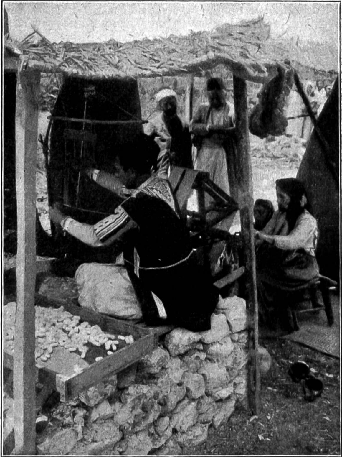
Seidenindustrie im nördlichen Syrien (asiat. Türkei). Die Cocons (eingespinnene Seidenraupen) werden gekocht; dadurch löst sich das Fadenende. Der Arbeiter verbindet mehrere der kaum sichtbaren feinen Fäden und befestigt sie am Haspel, der von einer Frau gedreht wird.
